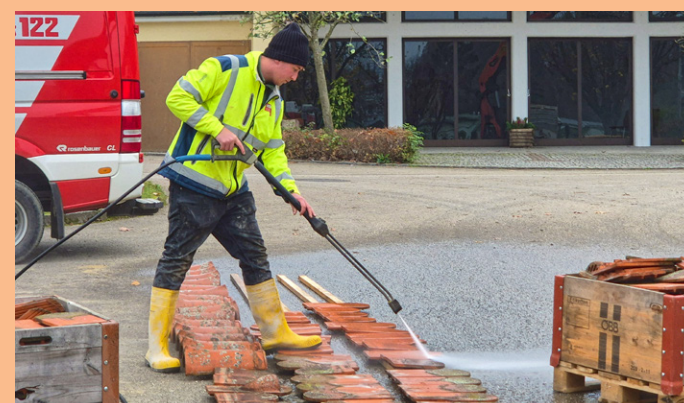
Am 2. November deckten Feuerwehrmänner das Dach des Pfarrheims ab. Alle Schindeln wurden gewaschen, neue Laternen angebracht und dann wieder aufgedeckt. Foto: Pfarre
