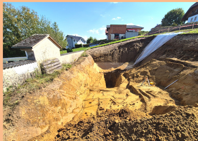
Eine tiefe Grube wurde für die Dränage oberhalb des Friedhofs ausgehoben. Foto: Pfarre
